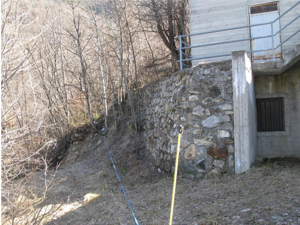
Dettaglio della muratura in pietra e malta che riveste una parte della struttura basale del serbatoio di Preyl.
