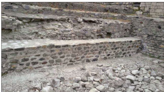
6. Ricostruzione di una delle gradinate crollate nell'area della scena, fase di finitura del primo gradone in basso. (G. Luberto)
