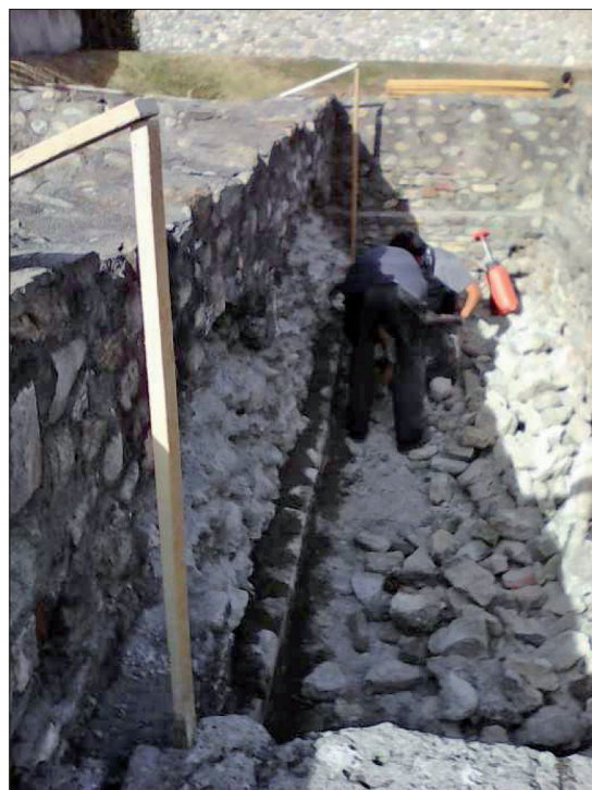
7. Fase di ricostruzione della muratura in uno degli ambienti a nord-ovest della scena. (G. Luberto)
