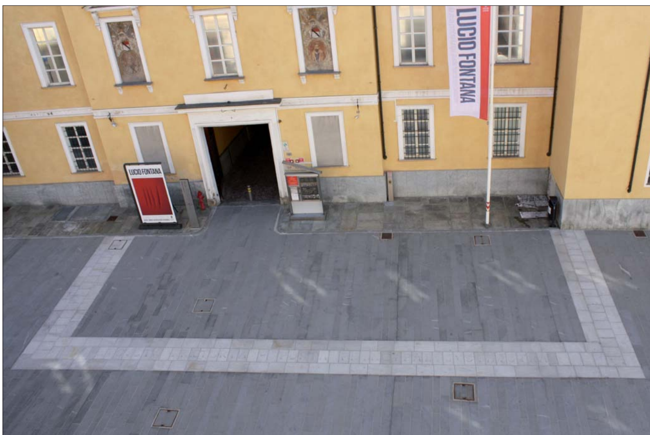
1. La nuova pavimentazione con la trasposizione in superficie di parte del perimetro della torre orientale della porta Principalis sinistra . (S.P. Pinacoli)
