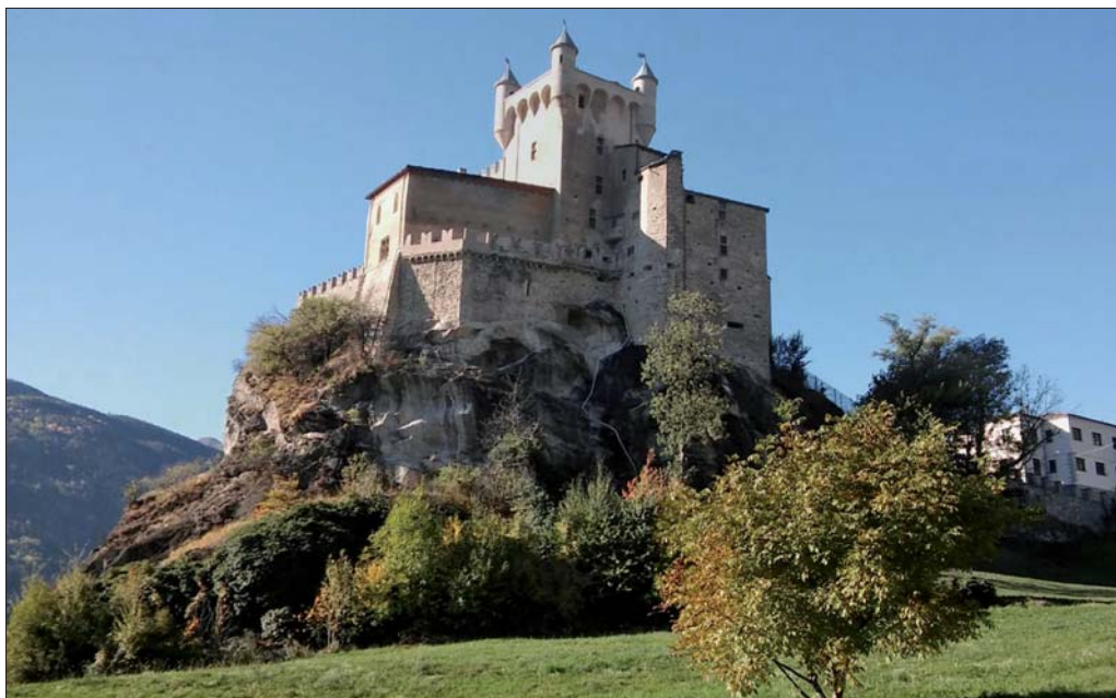
1. Il castello visto da sud-ovest. (M. Pesciarelli)
