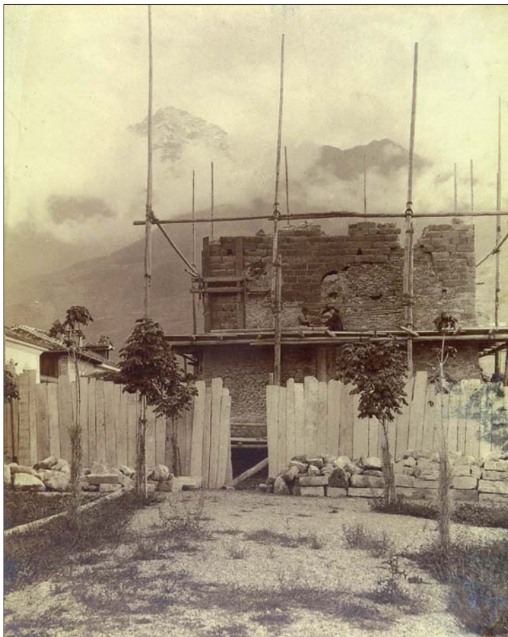
8. Il cantiere di restauro della torre nel 1891-1892. (Archivi beni archeologici)
