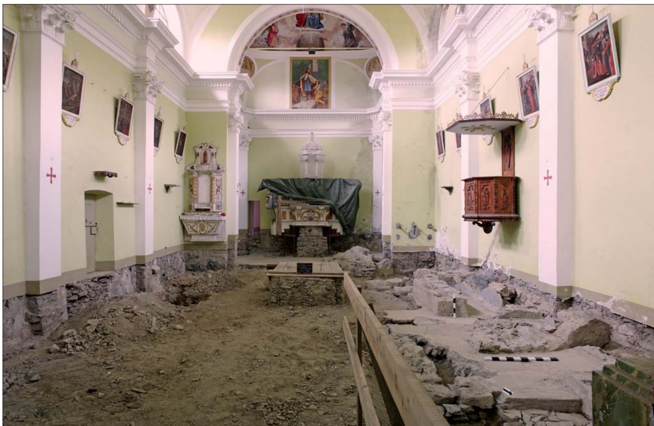
1. La navata della chiesa in corso di scavo. (P. Gabriele)
