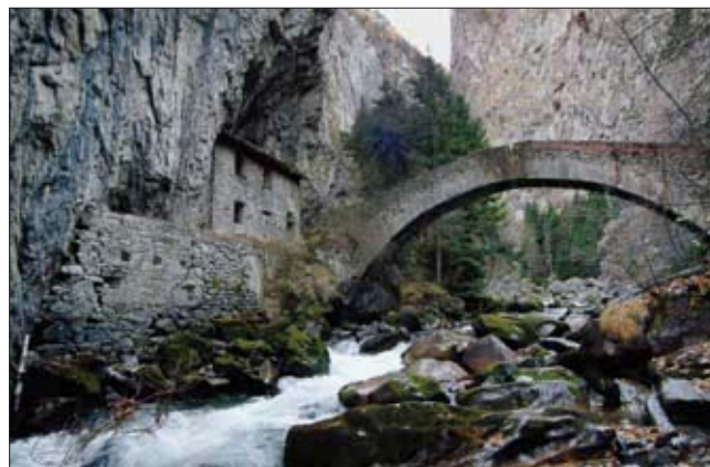
1. Spalla del ponte di epoca romana e porzione superstite del vecchio stabilimento dei bagni visto da valle. (GeoForm s.a.)
