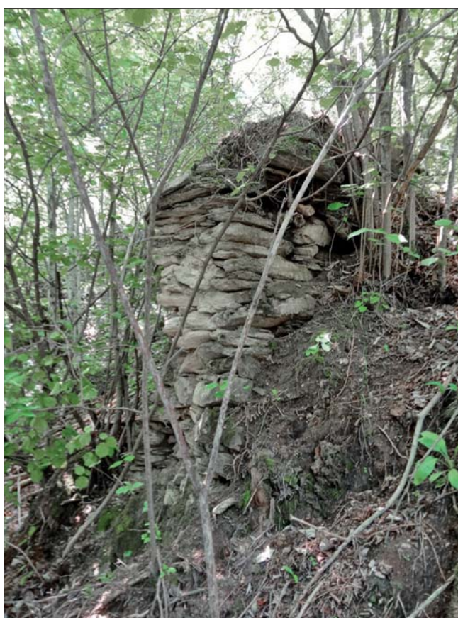
5. Spalla di monte del ponte-canale. (E. Bovet)
