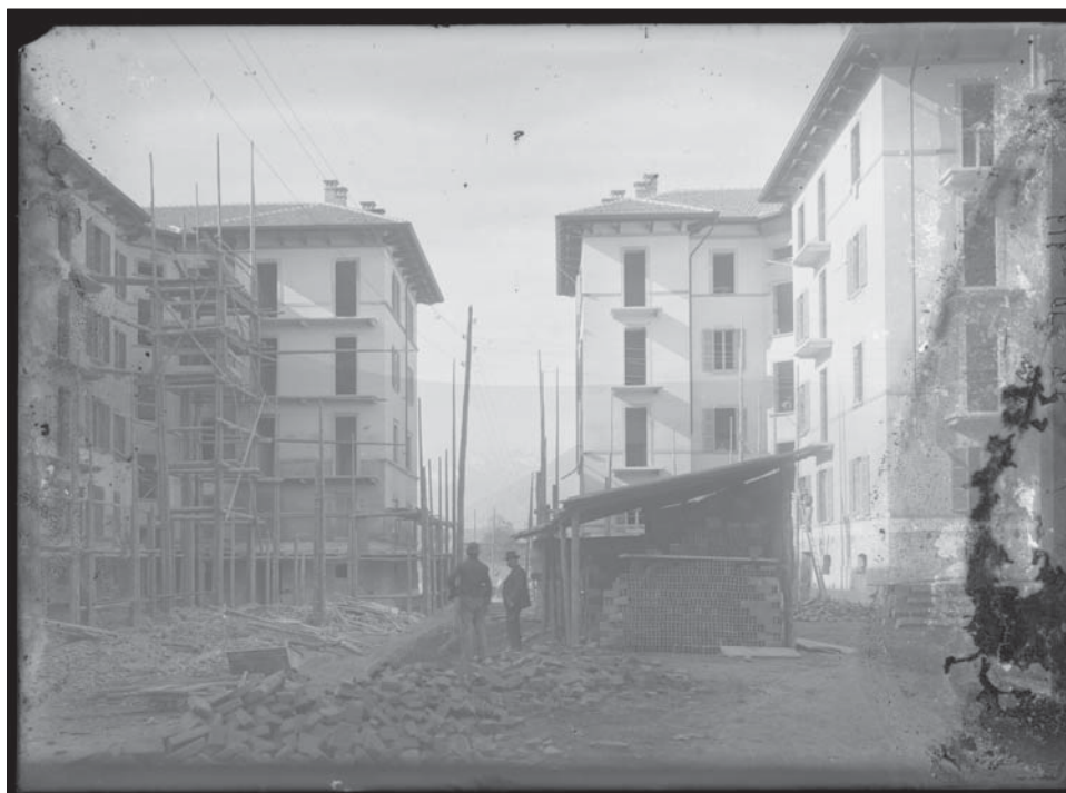
1. La construction des maisons « Giachetti ». (FNC, 1919-1920)
