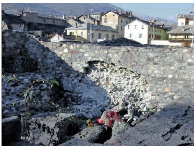
1. Il crollo del materiale nelle murature degli ambienti della scena. (P. Bancod)
