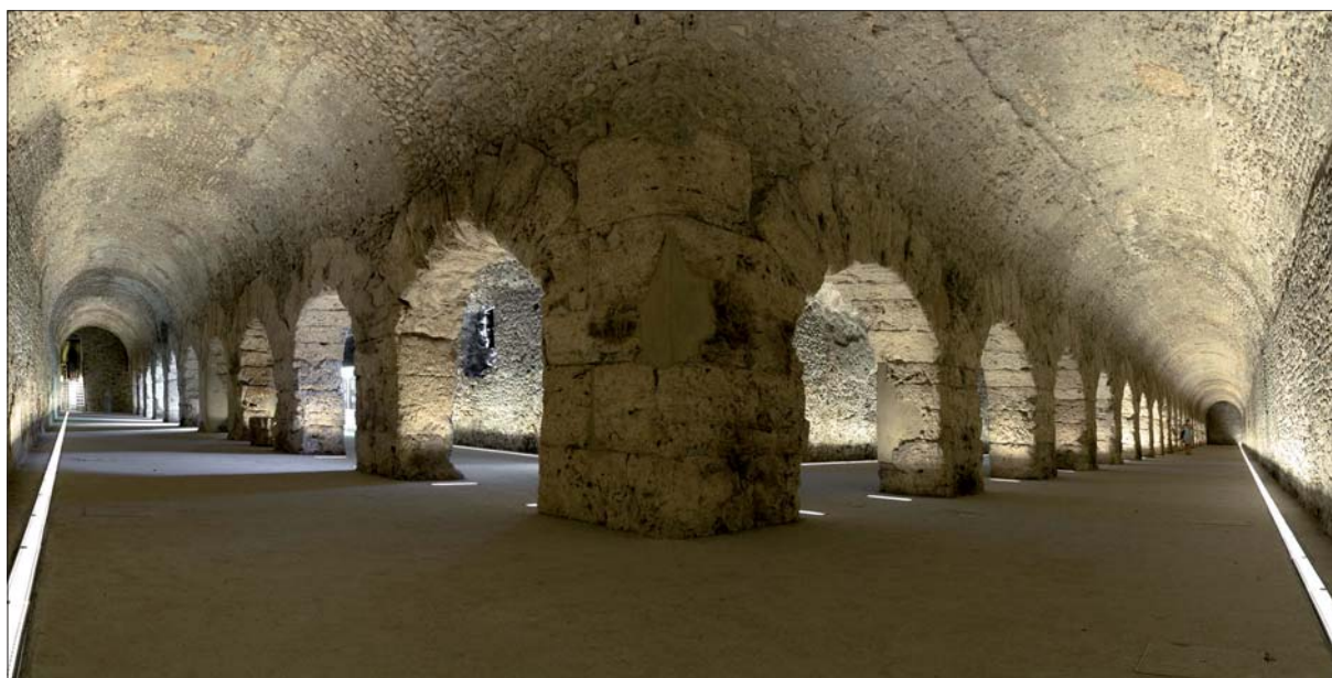
1. Le gallerie est e nord a intervento ultimato. (ERCO)
