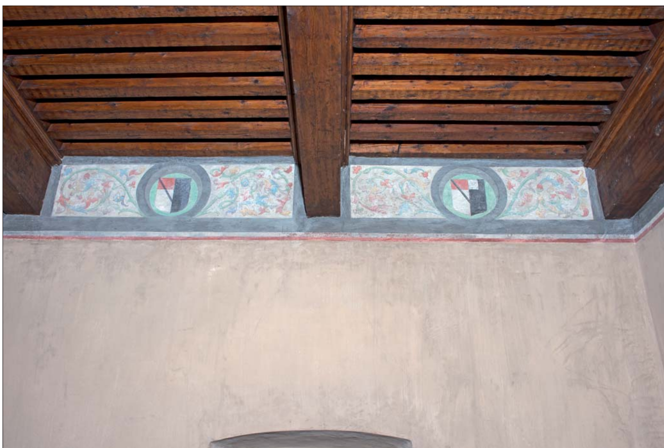
15.-16. Camera di Marguerite de La Chambre, prima e dopo il restauro. (P. Minioni)
