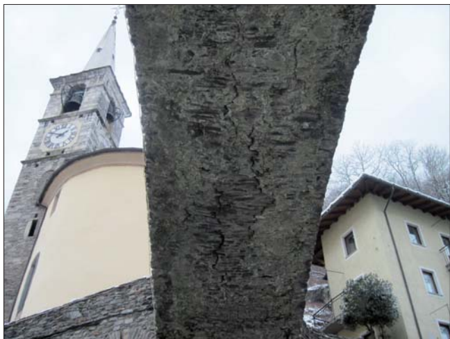
2. Fontainemore, ponte storico e chiesa. (A. Raso)
