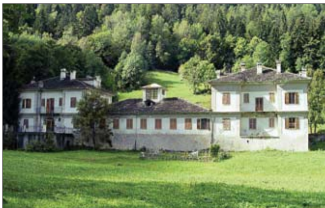
24a.-b. L'edificio termale prima che iniziassero i lavori di recupero e rifunzionalizzazione, autunno 2002. (E. Viale)
