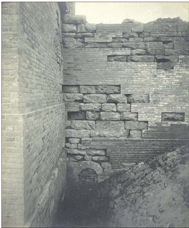
11. Dettaglio del restauro nell'angolo sud-est, fra la torre e il muro di cinta romano. (Archivi beni archeologici)
