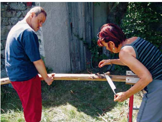
Lavori di falegnameria a Chevrière, Parco del Mont Avic con i volontari
