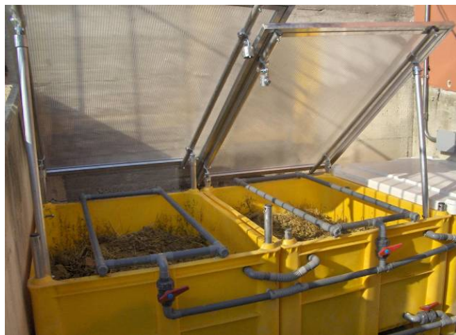
Figura 35: Come alternativa al cemento, i sistemi di biodegradazione possono essere isolati con contenitori in polietilene, come nel caso del Biobac® commercializzato da Mybatec®.
