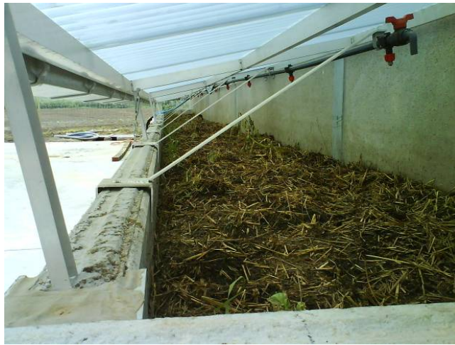
Figura 32: Distribuzione del liquido contaminato sulla superficie filtrante per mezzo di ugelli (foto: POVLT).
