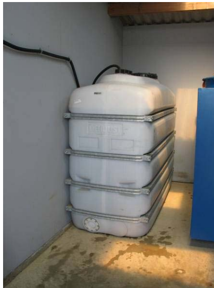
Figura 27: Esempio di un serbatoio di raccolta in polietilene con capacità di 4000 l, collocato fuori terra (foto: pcfruit).
