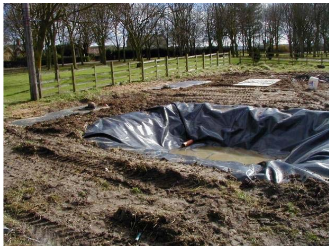
Figura 34: Come alternativa al cemento, i biobed possono essere isolati con materiali plastici quali polimeri EPDM (foto: ADAS)
