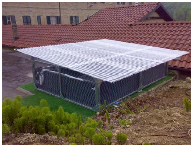
Figura 51: Sistema Heliosec® installato presso l'azienda Fontanafredda di Serralunga d'Alba (CN). La vasca di raccolta illustrata in figura è collegata con un'apposita tubazione all'area attrezzata per il riempimento ed il lavaggio delle irroratrici, in maniera tale che le acque reflue contaminate con agrofarmaci vi siano convogliate direttamente (foto: Syngenta).
