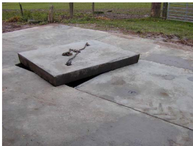
Figura 28: Esempio di una vasca di raccolta in cemento della capacità di 5000 l, ricavata al di sotto dell'area attrezzata per il riempimento ed il lavaggio delle irroratrici, e dotata di una valvola per escludere la raccolta dell'acqua piovana (foto: pcfruit).
