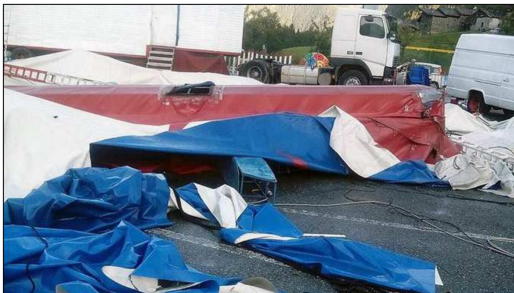
Fig n.21: padiglione di circo crollato durante il temporale a Brusson ( www.ansa.it )
