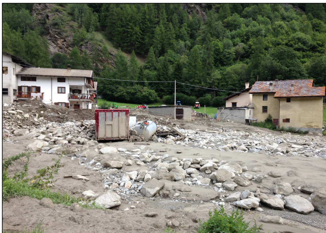
Fig n.34: comune di Ollomont – particolare alluvionamento
