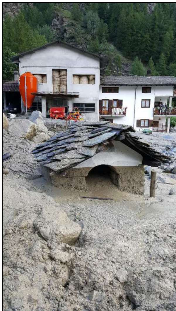
Fig n.31: comune di Ollomont – particolare alluvionamento
