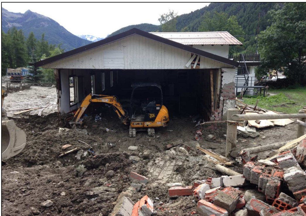
Fig n.33: comune di Ollomont – particolare alluvionamento
