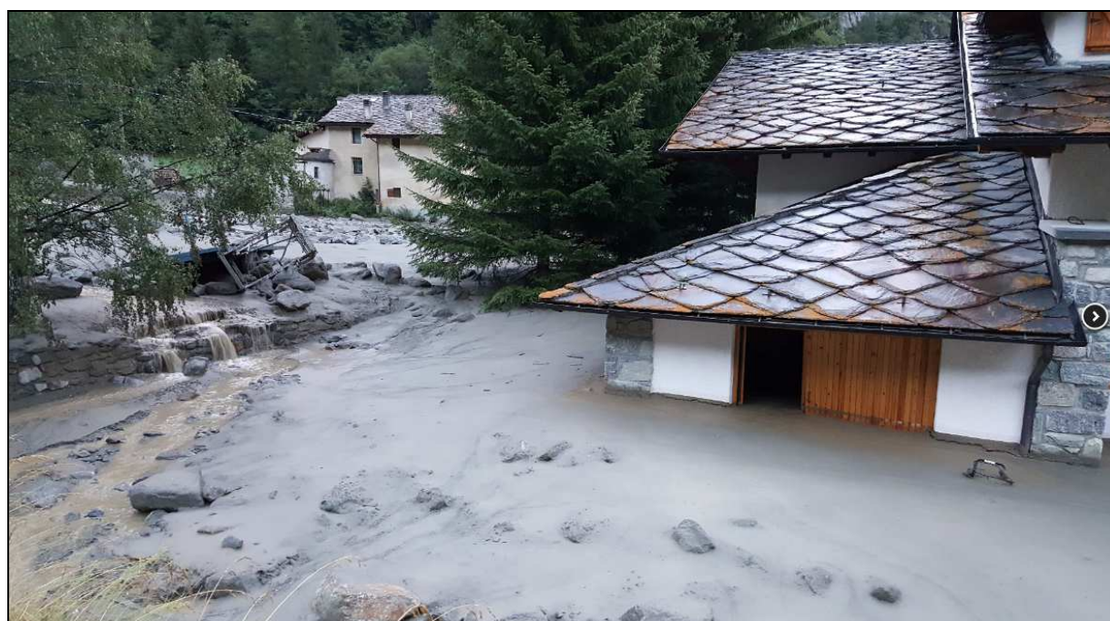
Fig n.32: comune di Ollomont – particolare alluvionamento
