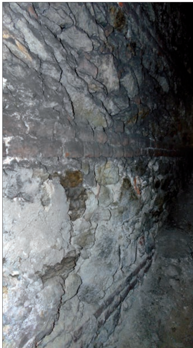
20. Muro di spina, fondato sulla roccia, in pietra e malta con corsi in mattoni.
