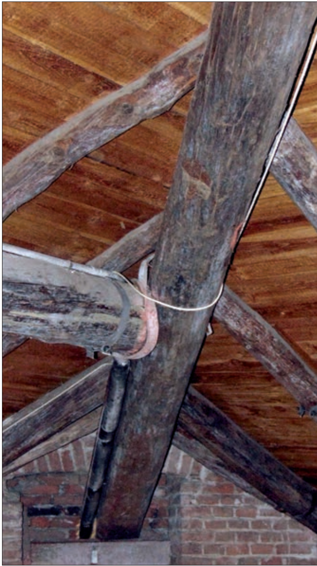
22. Particolare dell'orditura in legno del tetto e muro in mattoni pieni. (C.F. Quiriconi)
