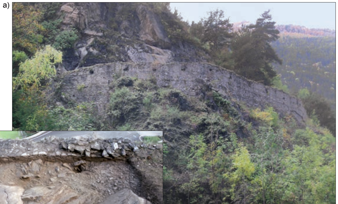
5a.-b. Avise, Runaz. a) Sostruzioni della strada romana, b) la sede stradale messa in luce durante lo scavo. (A. Armirotti)
