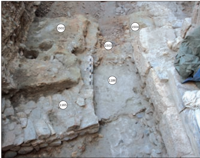
11. Vista da nord del sedime del canale a est della porta. (S.E. Zanelli)
