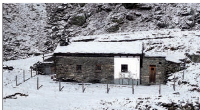
27. Valpelline, bivacco Molline: tipologia alpeggio con copertura in lamiera. (M. De Pascalis)
