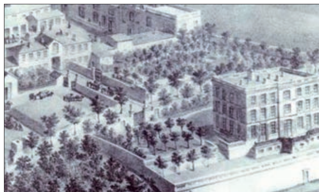
2. François Coignet, maison à Saint-Denis , 1853-1855.
