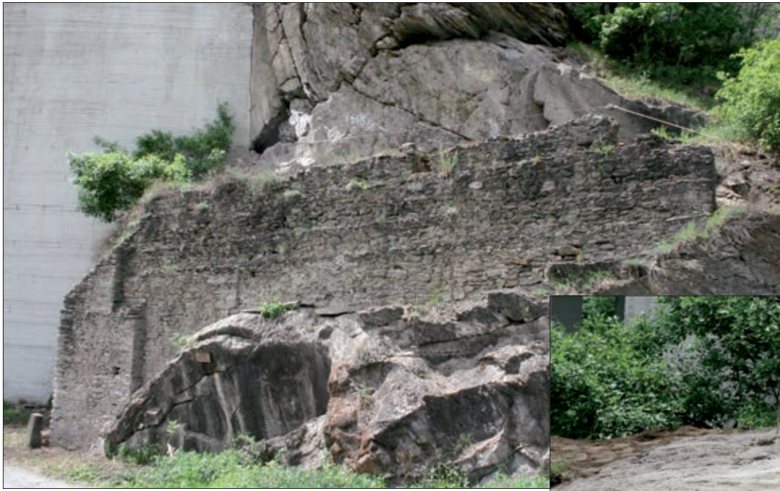
4a.-b. Introd, Champrotard. a) Sostruzioni della strada romana, b) la sede viaria costituita da roccia naturale. (A. Armirotti)
