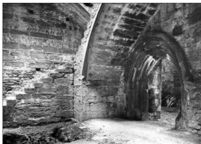
3. Il cortile interno prima della ricostruzione D'Andrade (1898-1899): si noti il vuoto al centro, oggi occupato dal pozzo. (Archivi catalogo beni culturali)
