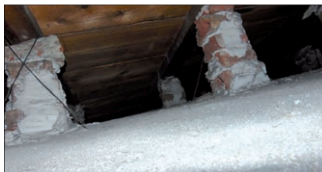
21. Estradosso della volta a botte e pilastrini in mattoni a sostegno del pavimento in legno del piano terreno.
