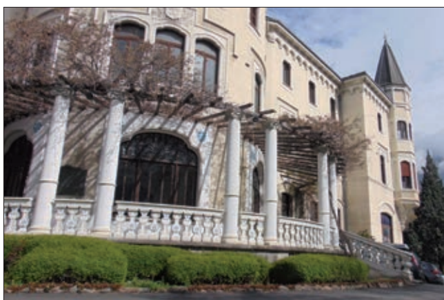
11. Facciata sud-est con bow-window. (C.F. Quiriconi)
