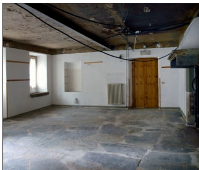
3. Il salone prima dell'inizio dei lavori. (L. Fromage)
