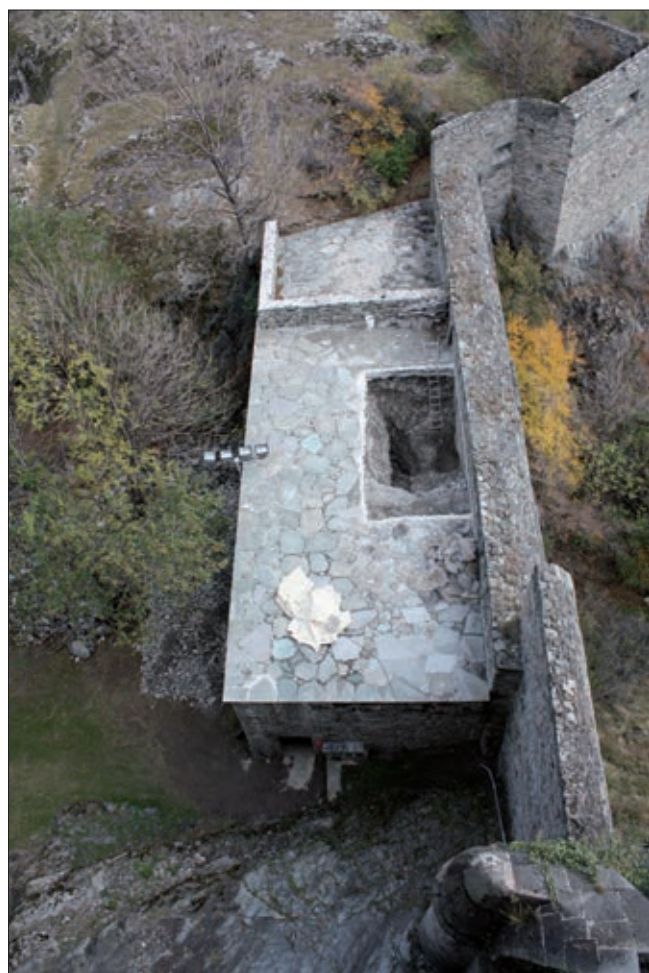
6. L'area denominata "ex scuderie" all'avvio dei lavori. (G. Sartorio)
