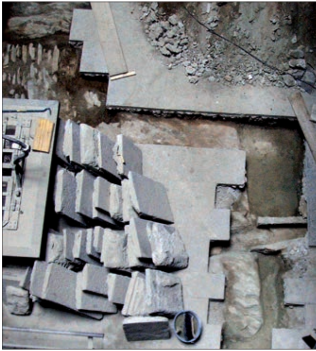
4. Vista del cortile interno durante i lavori del 2005. Visibile tra le lastre rimosse la traccia del taglio praticato nel substrato roccioso. (M. Cortelazzo)
