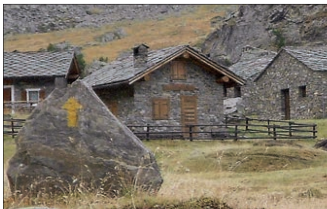
26. Cogne, bivacco Gontier: tipologia chalet in pietra con copertura in lose. (M. De Pascalis)
