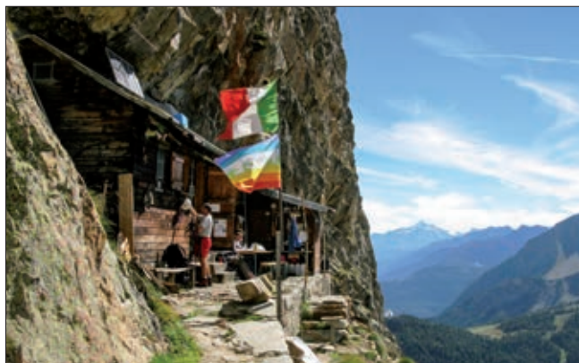
25. Courmayeur, bivacco Borelli-Pivano: tipologia chalet con tetto ad uno spiovente, sempre in lamiera. (E. Romanzzi)
