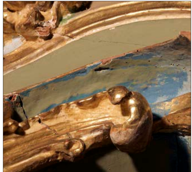
7. Altare di San Francesco. I diversi strati di colore erano riscontrabili anche prima di effettuare tasselli di ricerca. (Pm. Reboulaz)
