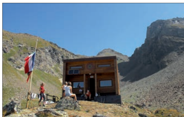
37.-38.-39. Bionaz, bivacco Chentre-Bionaz a 2.530 m s.l.m. (R. Andrighetto)
