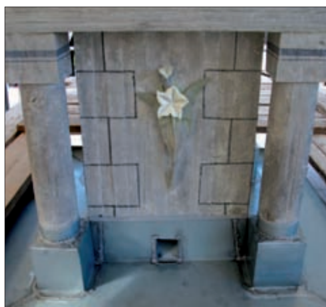
9. Intervento completato con rivestimento metallico. (D. Costantini)
