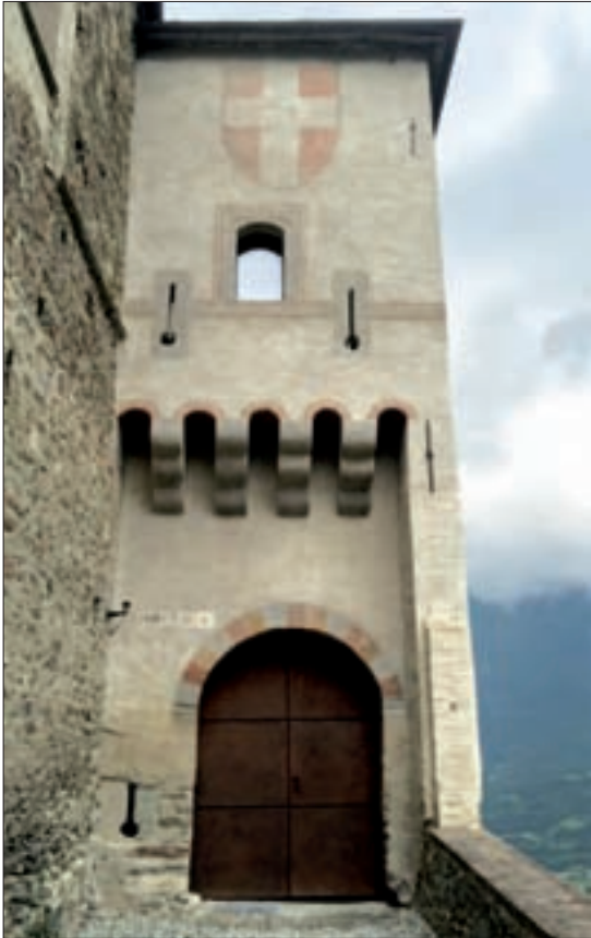
1. Rivellino d'ingresso dopo il restauro visto da ovest. (P. Fioravanti)
