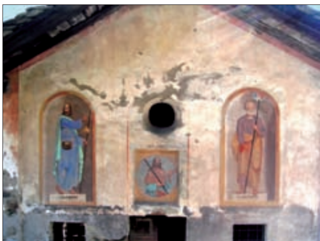
4. La facciata prima dell'intervento di restauro. (L. Bonetti)
