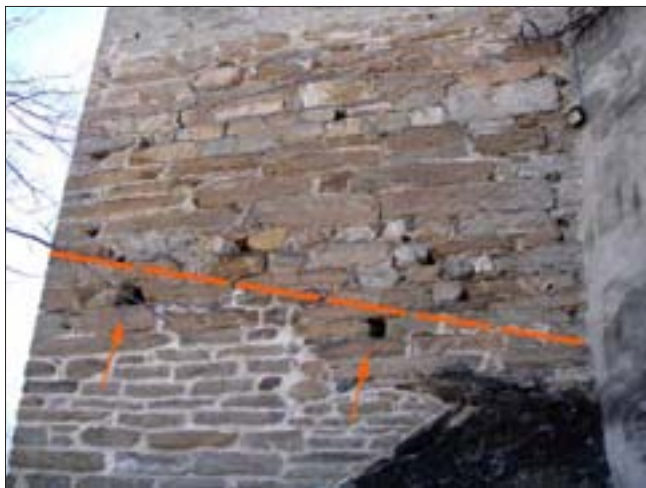
13. Fronte meridionale della torre di nord-ovest con indicazione dei buchi pontai e della salita al camminamento di ronda, cfr. fig. 9, C. (M. Cortelazzo)
