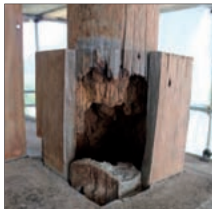
7. Stato di conservazione della base di una colonna. (G. Di Carlo)
