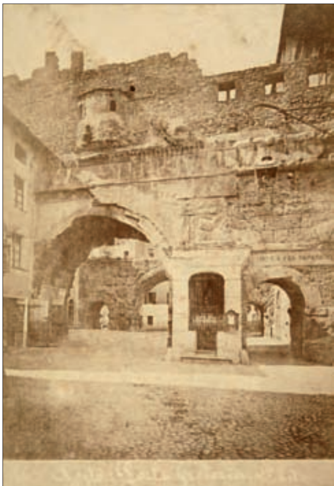
1. L'edicola votiva in una fotografia della Porta Prætoria antecedente il restauro Bérard del 1880-1881. In alto sono ancora visibili i resti della medievale cappella della Santissima Trinità. (Archivio dell'Ufficio beni archeologici della Soprintendenza per i beni e le attività culturali della Valle d'Aosta)
