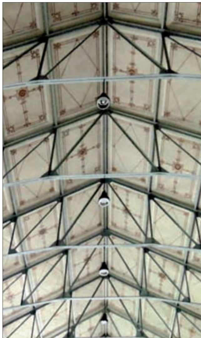
9. Particolare della copertura. (C.F. Quiriconi).
