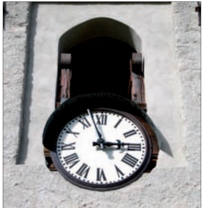
11. Particolare della facciata sud del campanile a fine intervento. (G. Di Carlo)
