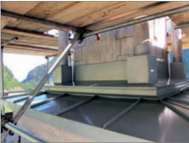
10. Nuovo rivestimento metallico in zinco-titanio. (D. Costantini)
