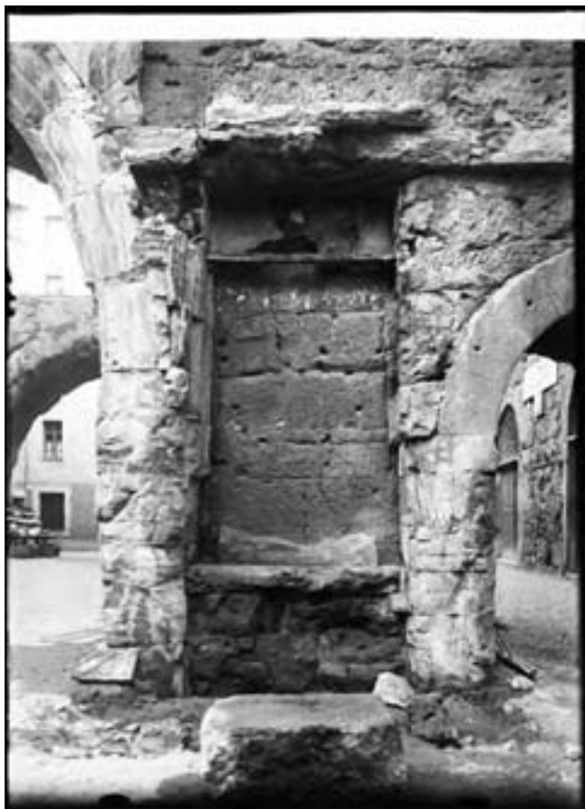
10. La nicchia vuota, dopo la demolizione dell'edicola nel 1932, mostra la sua struttura interna in puddinga. (Archivio dell'Ufficio beni archeologici della Soprintendenza per i beni e le attività culturali della Valle d'Aosta)
