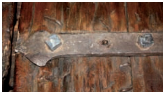
2. Particolare dei nuovi ancoraggi meccanici. (S.P. Pinacoli)
