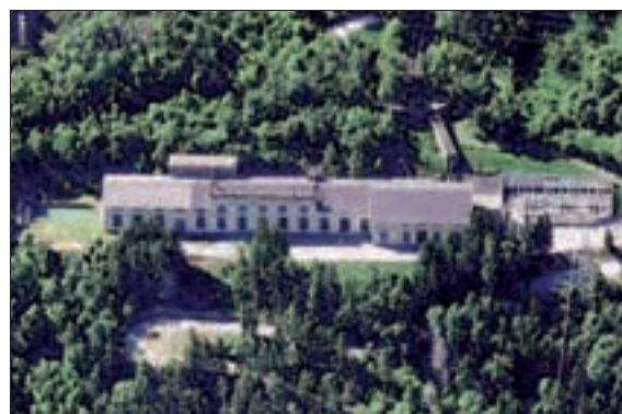
22. Villeneuve, località Chavonne, centrale idroelettrica. (Dal Geoportale SCT - RAVA)
