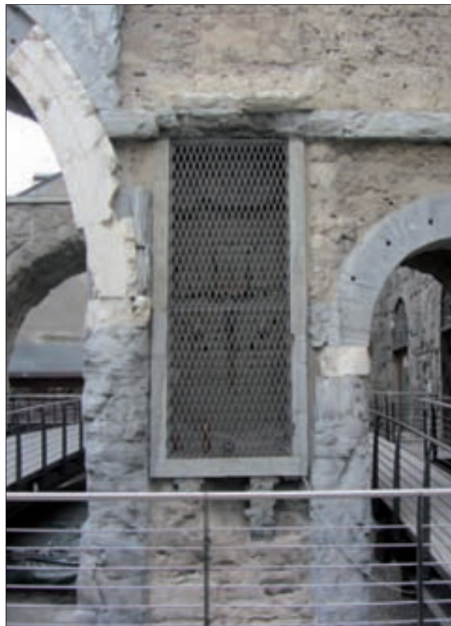
11. La nicchia come si presenta oggi, coperta dalla grata posta in loco dopo l'intervento del 1932. (M.C. Fazari)
