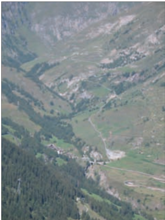
2. Particolare della strada secondaria che da Pont-Serrand devia verso il Vallon des Chavannes. (G. Sartorio)
