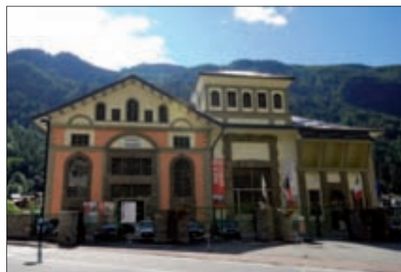
23. Valtournenche, località Maen, centrale idroelettrica. (D. Martinet)
