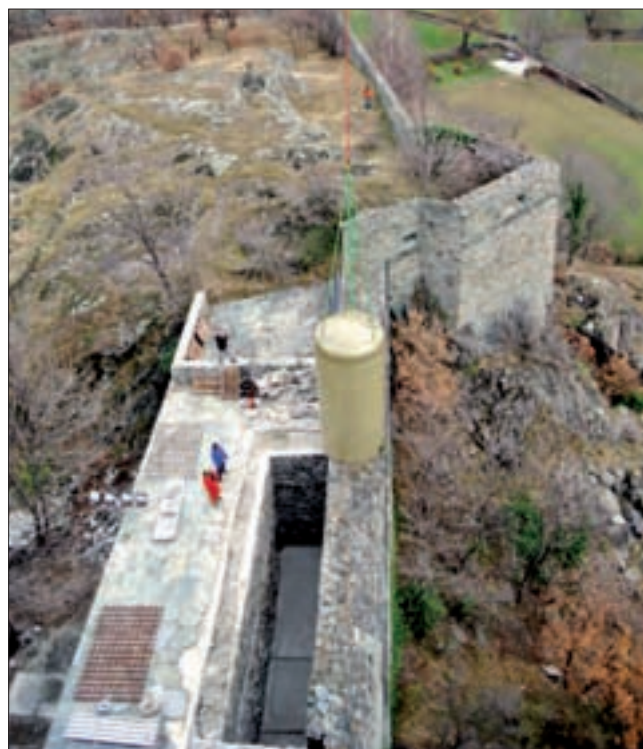
1. Trasporto, con l'elicottero, di un serbatoio in vetroresina. (M. Pesciarelli)
