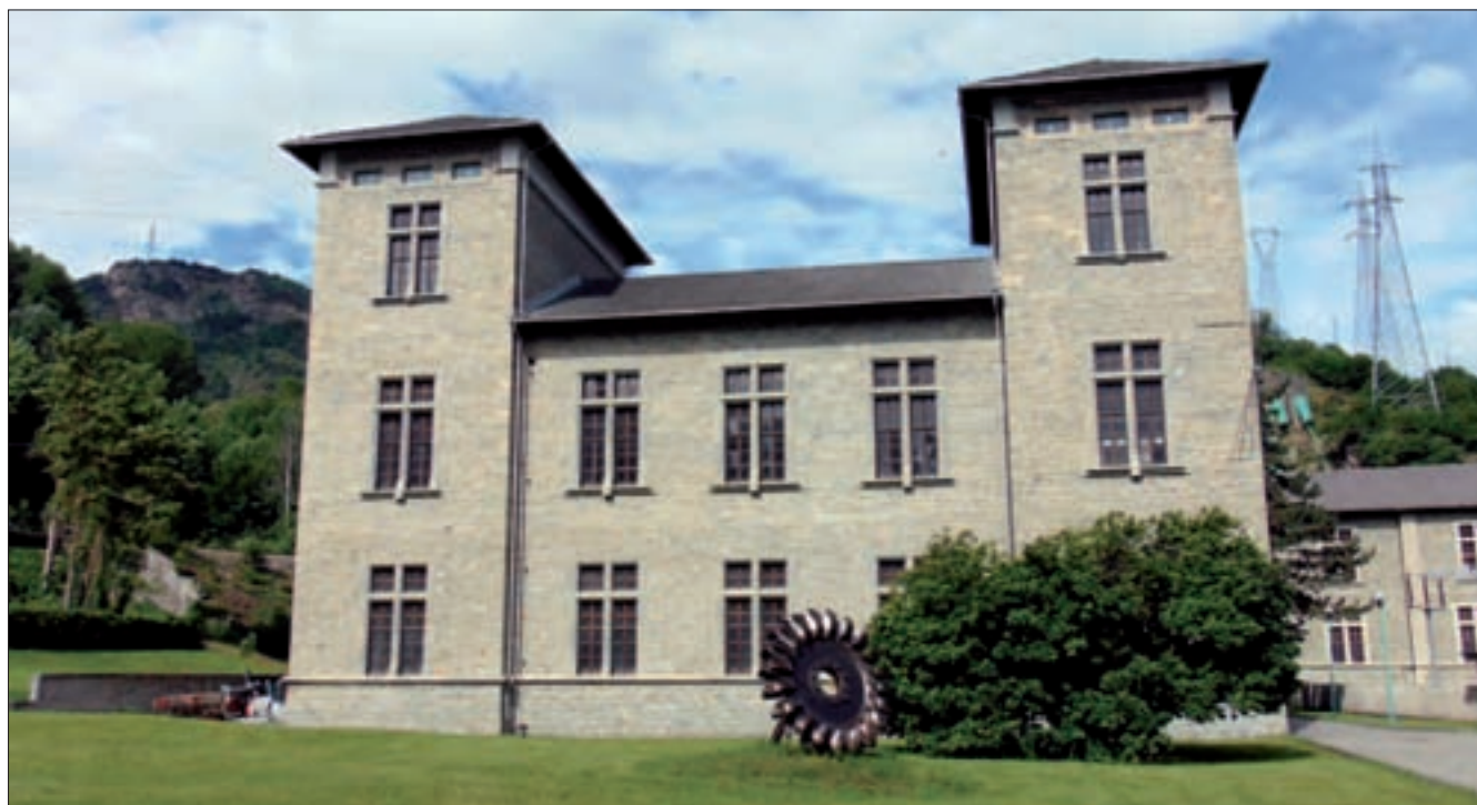
5. Centrale Champagne I, fronte est. (C.F. Quiriconi)
