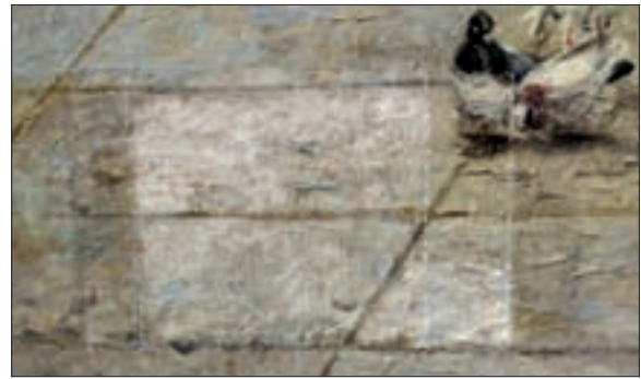
7. Prove di pulitura di superficie e di rimozione della vernice, luce diffusa. (Gallarini Bonollo S.n.c.)
