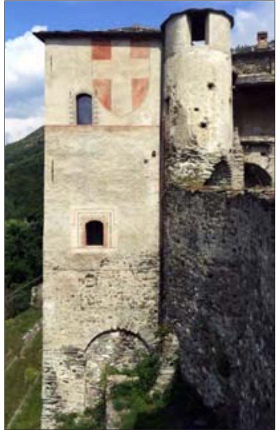
2. Rivellino d'ingresso dopo il restauro visto da est. (P. Celesia)
