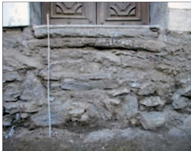
14. Scavo dell'intercapedine lungo l'ingresso ovest: la soglia precedente è più bassa di 15 cm ed è frantumata. (D. Costantini)
