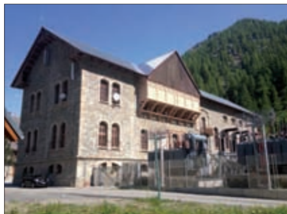
21. Gressoney-La-Trinité, centrale idroelettrica. (C.F. Quiriconi)
