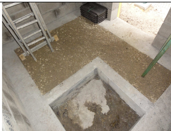
Intérieur de l'abri qui abrite le sismomètre pendant la construction
