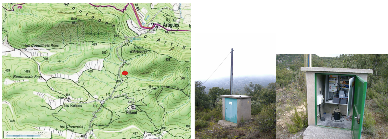
Figure 1: Site de la station sismologique large bande ARTF. Mise en oeuvre le 24 avril 2011
