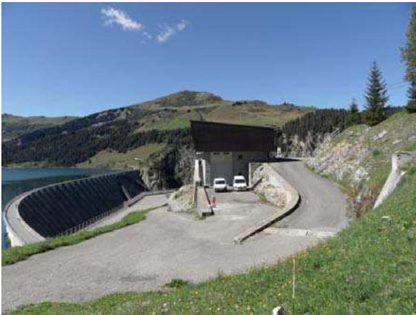
Accès à la galerie de surveillance de Roselend abritant la station Sismologique
