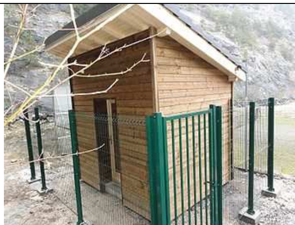
Construction abritant le capteur et l'électronique
