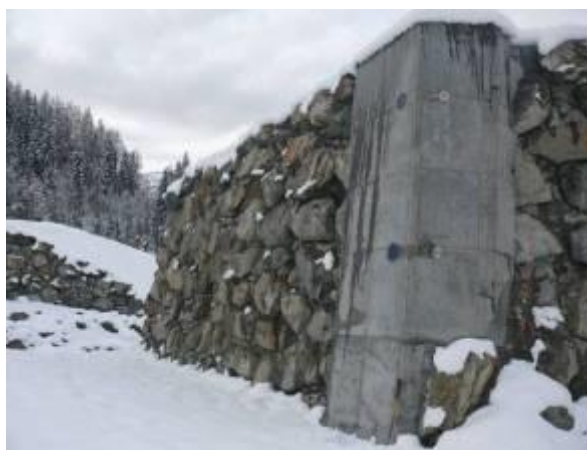
Tas freineur équipé de deux capteurs de pression et de vitesse
