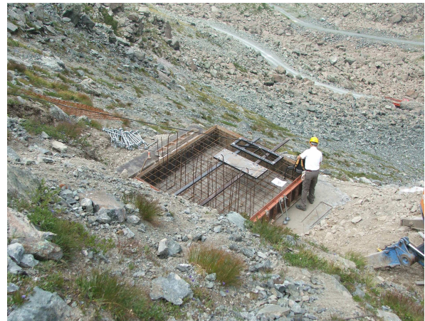
Réalisation de la fondation de l'obstacle (aout 2010)
