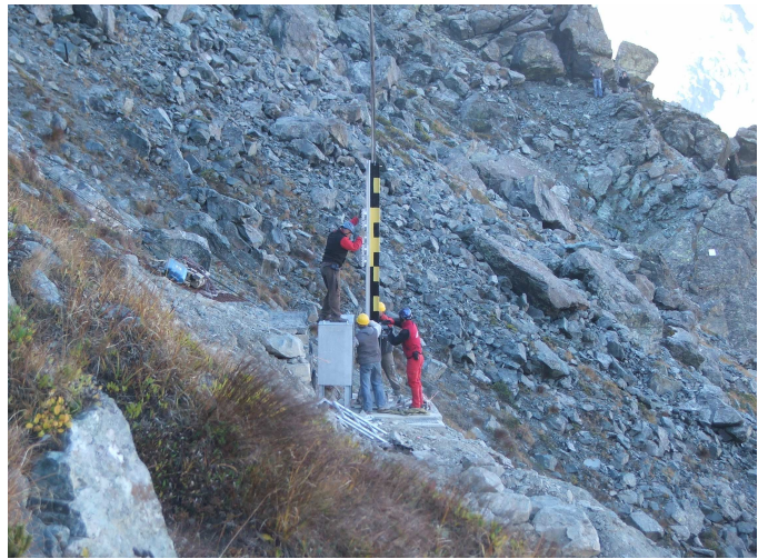
Installation de l'obstacle (septembre 2010)
