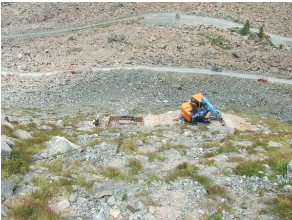
Réalisation de la fondation de l'obstacle (aout 2010)
