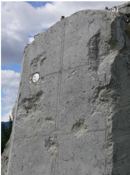
Dégâts occasionnés sur le tas 3 à la suite de l'avalanche du 17 février 2010 (a) et chambre de tirage endommagée par un engin de chantier (b)
