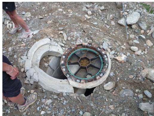
Dégâts occasionnés sur le tas 3 à la suite de l'avalanche du 17 février 2010 (a) et chambre de tirage endommagée par un engin de chantier (b)
