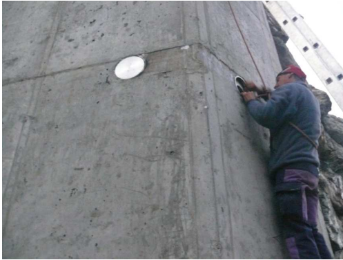
Travaux de génie civil pour les supports de capteurs et mise en place des capteurs (automne 2009)
