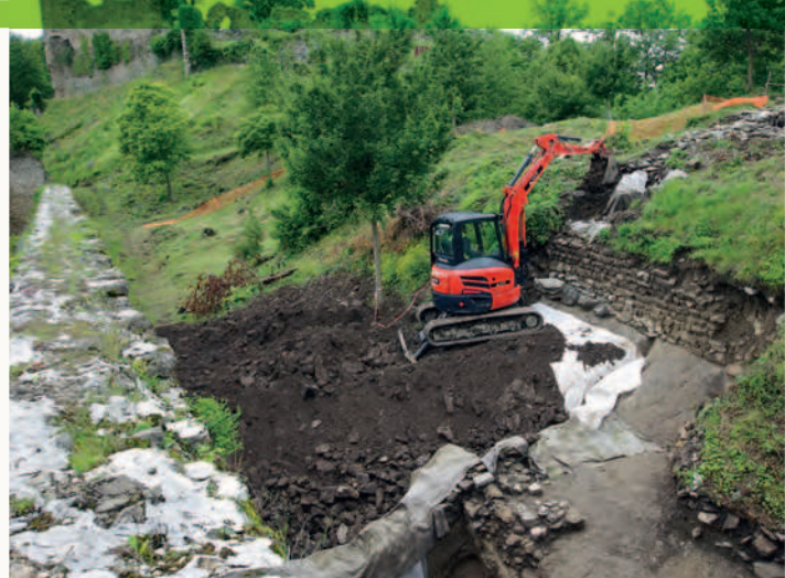
Château-Vieux d'Allinges (Haute-Savoie, Francia). Il reinterro delle rovine messe in luce dagli scavi archeologici, una volta terminato lo studio, è obbligatorio nel caso in cui non si possa intraprendere immediatamente un'azione conservativa. Foto C. Guffond – CG74.
