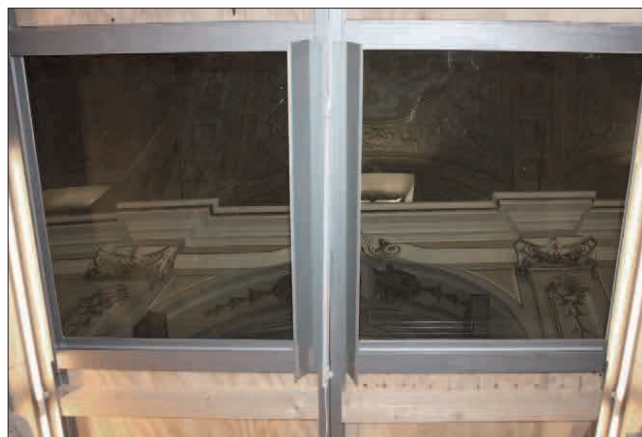
2. Gli elementi modulari del pavimento, in vetro e legno, visti dallo scavo. (A. Sergi)
