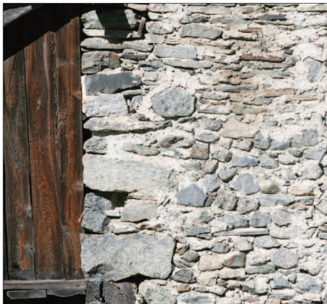
1. Muratura con conci irregolari, da intonacare. (C. Paternoster)
