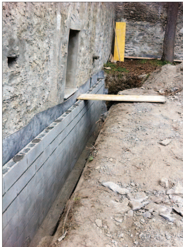
6. Les écuries pendant les travaux d'imperméabilisation et de réalisation d'un contre-mur ventilé. (A. Novel)
