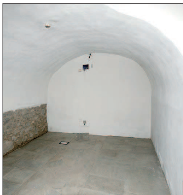
4. Le sous-sol des écuries à la fin des travaux. (A. Novel)
