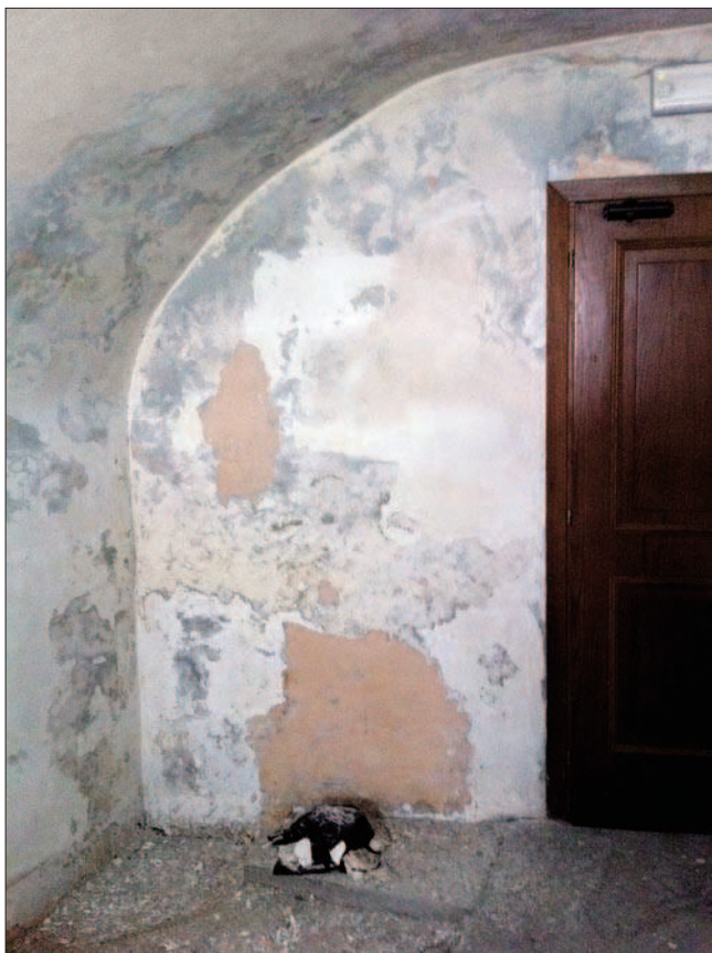
5. L'intérieur des écuries avant les travaux. (A. Novel)
