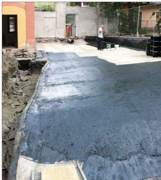
7. Imperméabilisation de l'extrados des voûtes des écuries. (A. Novel)
