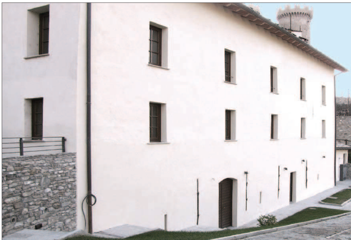
1. La façade Nord de la grandze après les travaux. (A. Novel)
