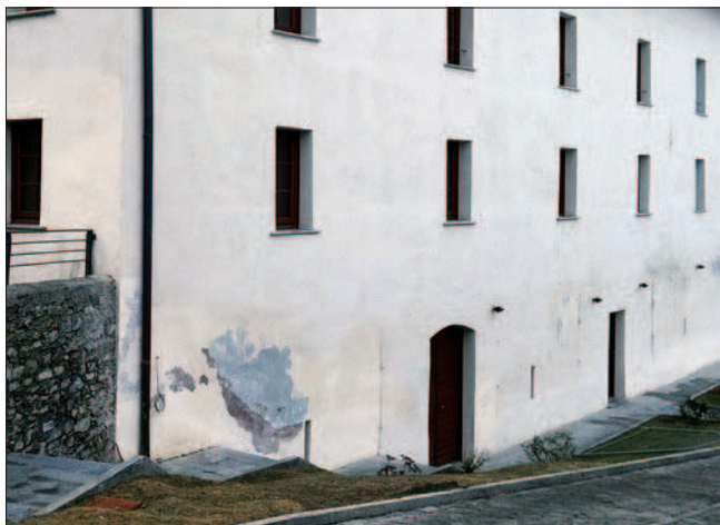
2. La façade Nord de la grandze avant les travaux. (A. Novel)
