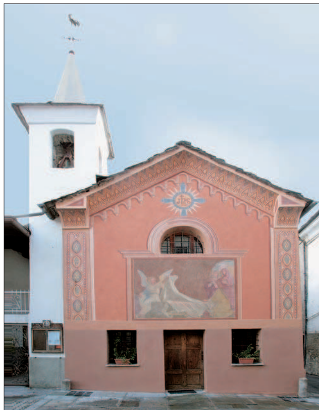
1. La facciata dopo l'intervento. (S.E. Zanelli)
