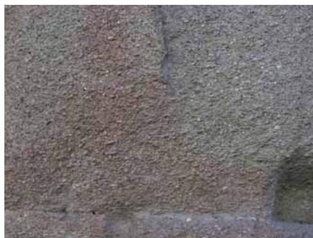
1. Aosta, Porta Prætoria. Alterazione cromatica visibile su un blocco di puddinga. (E. Conz)
