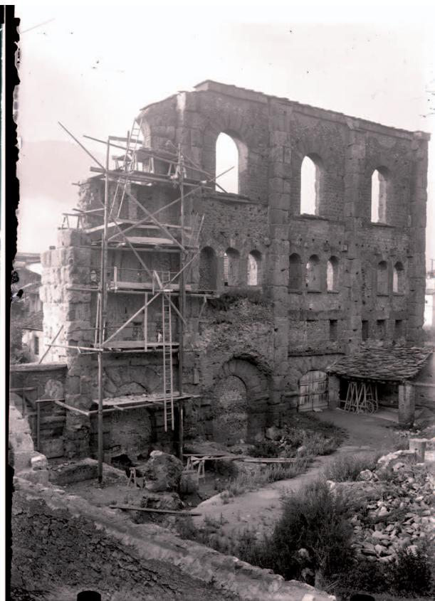
3. Controfacciata del Teatro dopo la demolizione degli edifici addossati e durante i primi consolidamenti effettuati negli anni 1931-1932. Scansione, dopo il restauro, della lastra in vetro negativa n. 147-343-779B con accanto l'inversione tonale effettuata mediante software.
