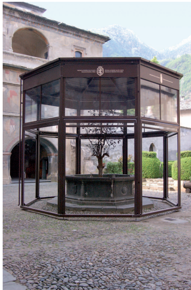
10. Padiglione dopo il montaggio, completo di tutte le parti di finitura. (M. Pesciarelli)
