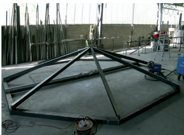
6. Particolare struttura della copertura durante la realizzazione in officina. (M. Pesciarelli)
