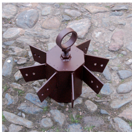
7. Nodo centrale di sostegno della copertura. (M. Pesciarelli)
