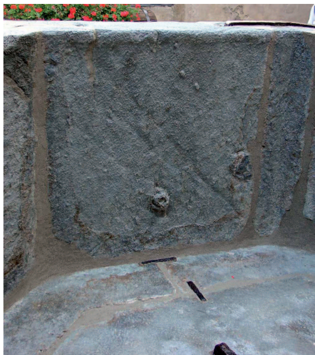
4. Interno della vasca dopo le nuove stuccature dei giunti realizzate con resina elastomerica, caricata con polveri di pietre verdi e grigie. (G. Di Carlo)
