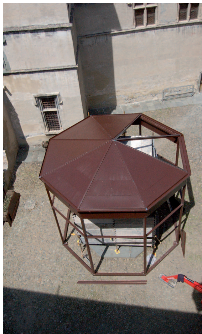
8. Assemblaggio della copertura. (M. Pesciarelli)
