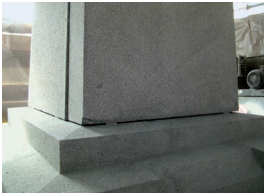
14. Si evidenzia la fase di disassamento delle lastre sopra la base e la posa dei due cunei per lato. (D. Bortot)
