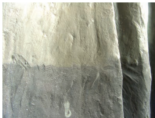
13. Fase di pulitura che mostra la diversità fra la coloritura nero verdastra e le zone già pulite. (D. Bortot)
