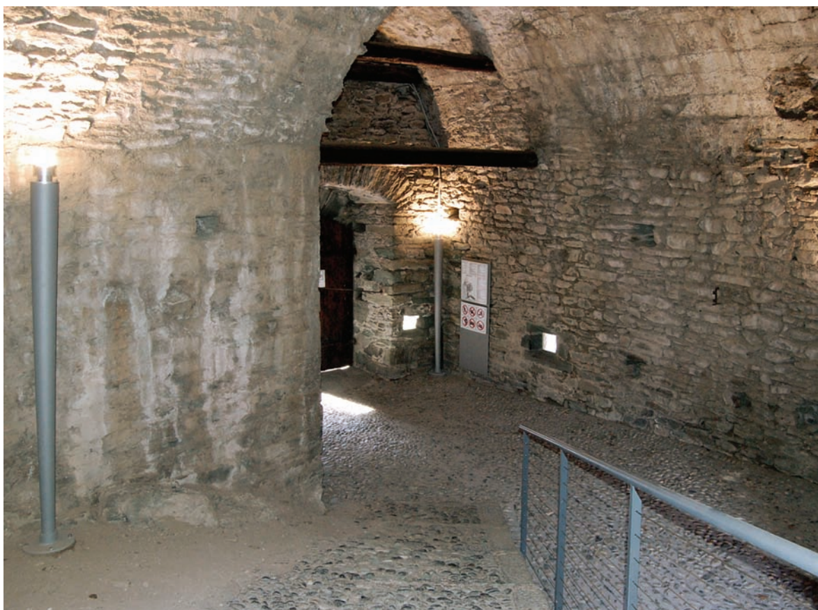
1. Vue de la zone d'accès. (M. Pesciarelli)
