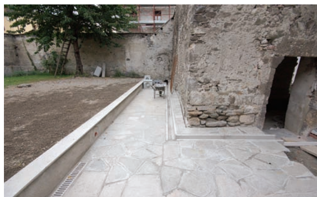
6. Pavimentazione zona esterna al muro nord, a lavori ultimati. (S. Martino)
