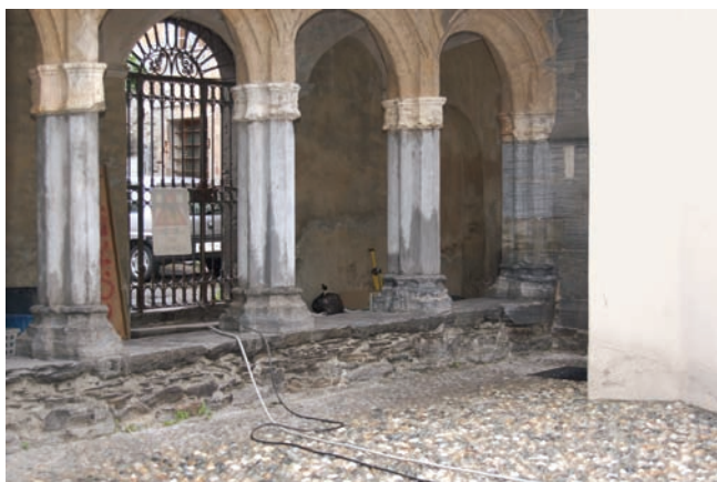
1. Vista della zona dell'ingresso prima dei lavori. (A. Novel)
