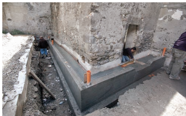
5. Intercapedine esterna al muro nord, durante la realizzazione. (S. Martino)
