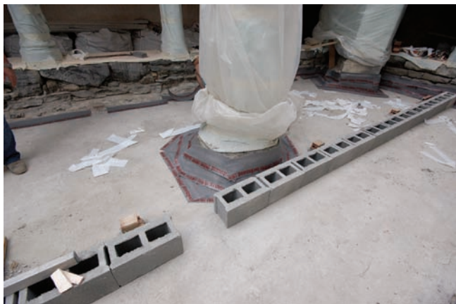
3. Particolare, durante l'esecuzione, della canalina centrale di raccolta delle acque. (S. Martino)
