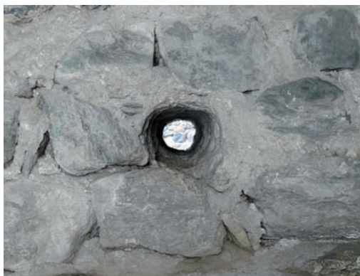
36. Una delle buche pontaipe vuote con l'impronta circolare del travicello. (E. Calcagno)
