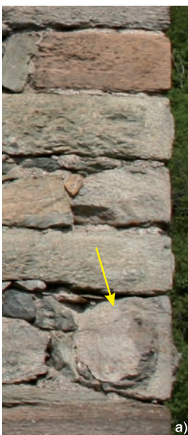
7. Particolare dei blocchi con la presenza di una bugna in rilievo nella parte bassa: a) angolo nord-est, b) angolo sud-est. (M. Cortelazzo)
