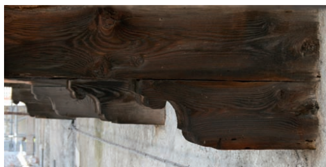
20. Particolare delle travi modanate datate con la dendrocronologia al 1664. (M. Cortelazzo)
