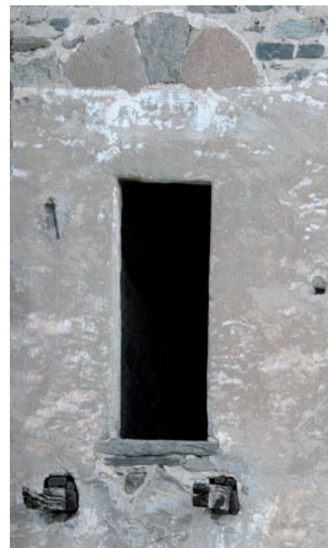
8. Il primitivo ingresso alla torre ricoperto da una stesura di intonaco tardomedievale. (M. Cortelazzo)
