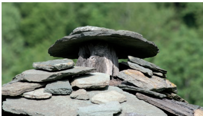
11. Particolare del colmo del tetto a quattro falde del 1417-1418. (M. Cortelazzo)
