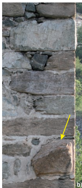
7. Particolare dei blocchi con la presenza di una bugna in rilievo nella parte bassa: a) angolo nord-est, b) angolo sud-est. (M. Cortelazzo)
