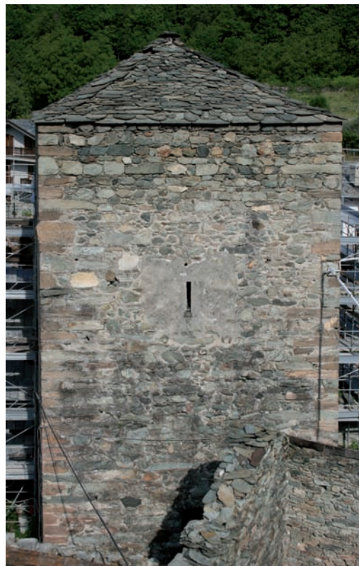
10. Lato est con l'originale feritoia di piccole dimensioni al centro della parete. (M. Cortelazzo)
