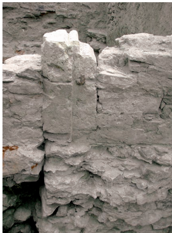
23. Particolare di uno stipite in travertino tra le strutture di Maison Chappuis, realizzato con un blocco di reimpiego che conserva tracce di decorazione dipinta. (M. Cortelazzo)
