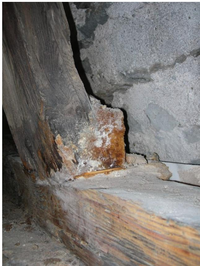
8 - 9. Particolari delle teste restaurate delle travi della struttura lignea della cuspide. (S. Leuratti)
