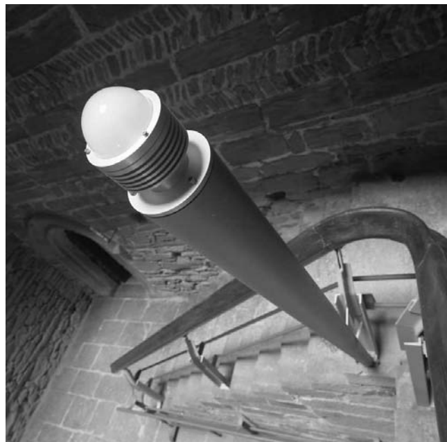
5. L'illuminazione dello scalone monumentale: particolare della torciera. (D. Cesare)
