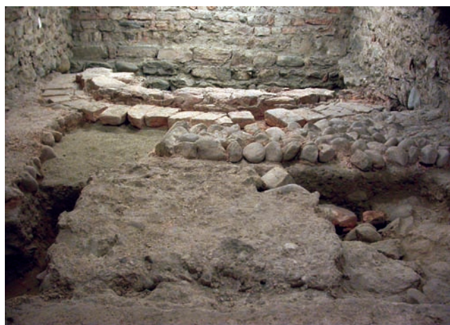
2. Aosta, cattedrale, navata centrale, battistero: in primo piano fondazione di basamento. (R. Dal Tio)
