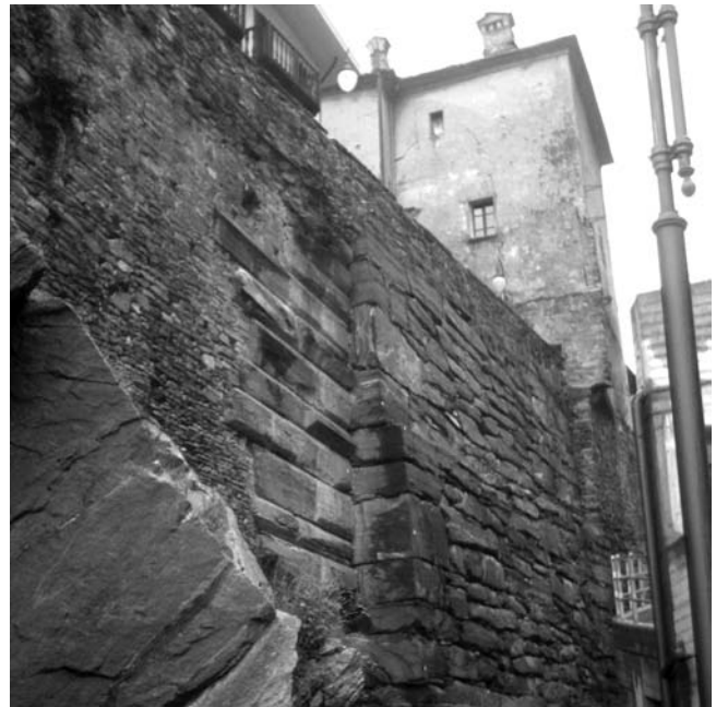
3. Un tratto delle imponenti costruzioni a sostegno del piano viabile romano. (S. Pinacoli)
