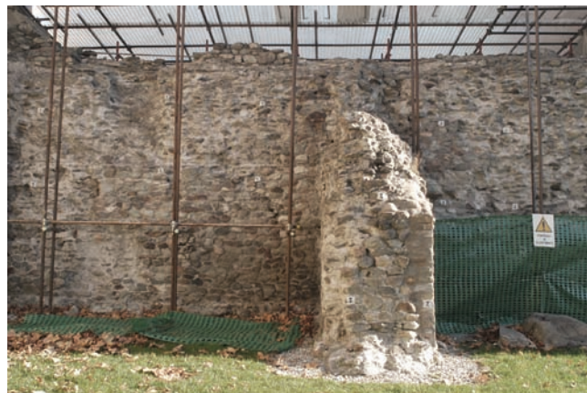
10. Tratto di mura sul lato sud interno con presenza di sperone. (P. Salonia)
