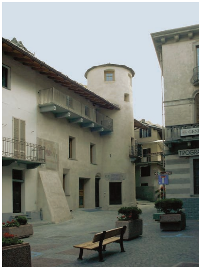
1. Verrès. Vue de l'ancienne "Maison La Tour" après les travaux de restauration. (E. Alliod)
