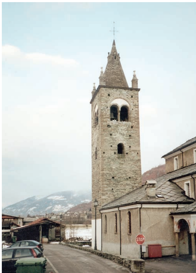
1. Il campanile dopo l'intervento. (A. Devoti)
