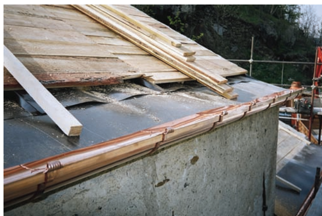
3. - 4. Particolari del ripristino della copertura; prima e dopo l'intervento. (F. Pizzini)
