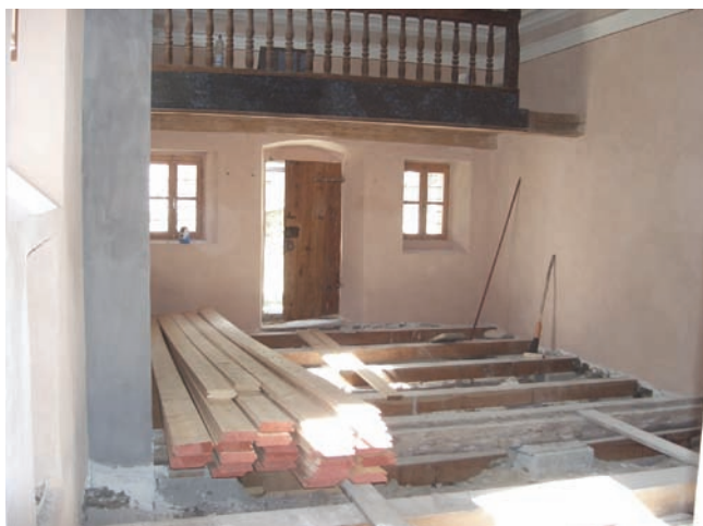
5. Rifacimento della pavimentazione interna della cappella. (F. Pizzini)
