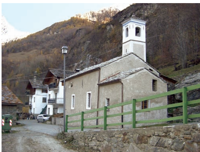
6. - 7. Vedute esterne del complesso, dopo l'intervento. (F. Pizzini)
