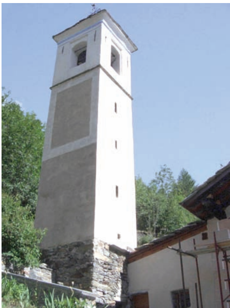
10. Il campanile al termine dell'intervento. (F. Pizzini)
