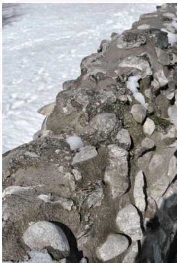
6. Consolidamento delle creste del sacco. Particolare delle nuove malte (più chiare) associate alle malte originali (C. Pedeli)
