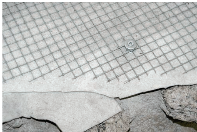
7. Particolare della copertura semovente, prima della gettata di malta. (C. Pedeli)
