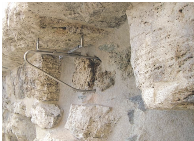
11. Prototipo di una mensola dinamica auto-regolabile. (Carpenterie Acerbi)
