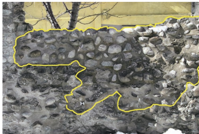
9. Consolidamento/ricostruzione del sacco funzionale alla tamponatura di un varco accessibile. (C. Pedeli)
