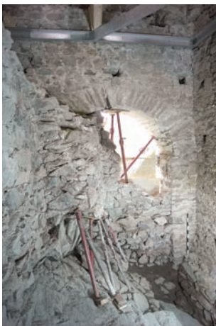
19. Ingresso (amb. 2), vano a scavo completato con arcata del lato est della prima fase costruttiva. (S.E. Zanelli)
