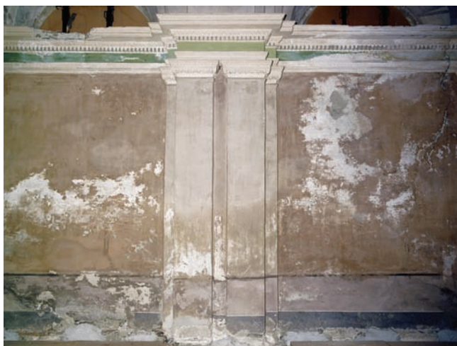
65. - 66. Dettagli del degrado causato dalle infiltrazioni di umidità. (P. Fioravanti)
