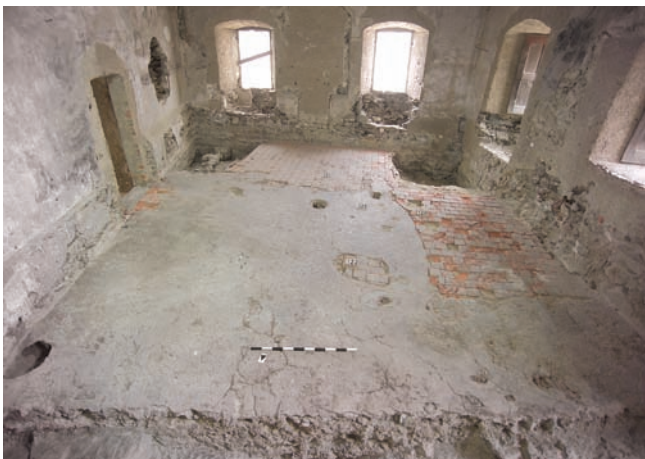
12. Torrione, interno (amb. 40), pavimentazione in cocchiopesto con vari rappezzi prima dell'inizio dei lavori. (S.E. Zanelli)
