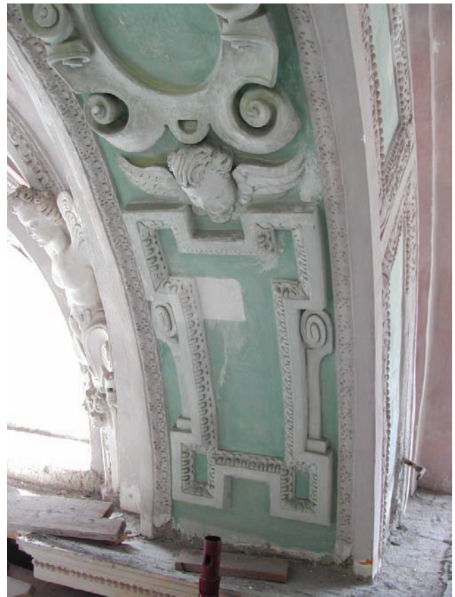
57. Sottarco, tassello con asportazione delle ridipinture. (P. Fioravanti)
