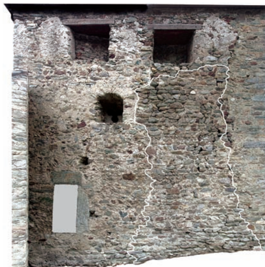
4. Torrione parete nord, evidenziato il lacerto di muratura della prima fase costruttiva. (Omografia R. Focareta, elaborazione M. Cortelazzo)
