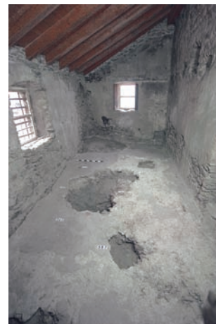
14. Locale annesso (amb. 41), veduta da nord prima dell'avvio dell'indagine stratigrafica. (S.E. Zanelli)
