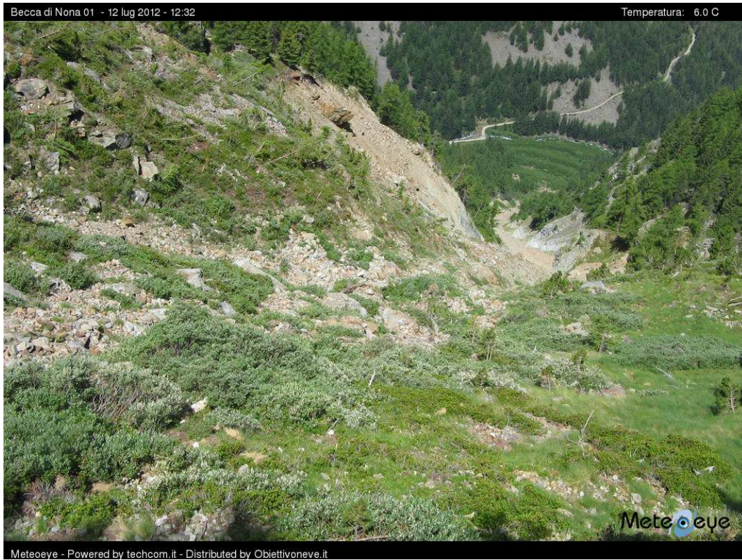
Foto 1: Vista del canale destro
