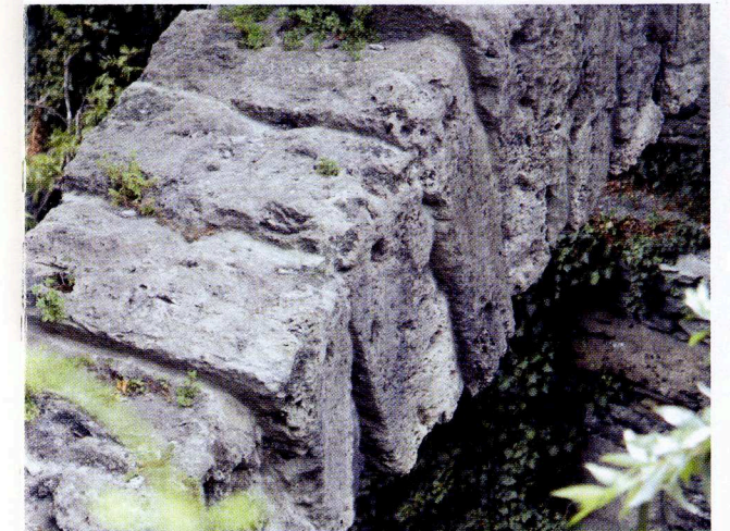
Détail des cavités dans les blocs
