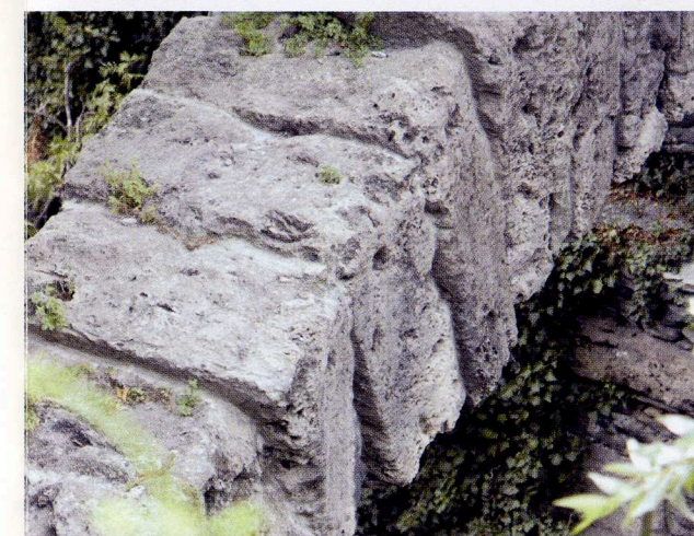
Particolare degli incavi per il sollevamento dei blocchi
