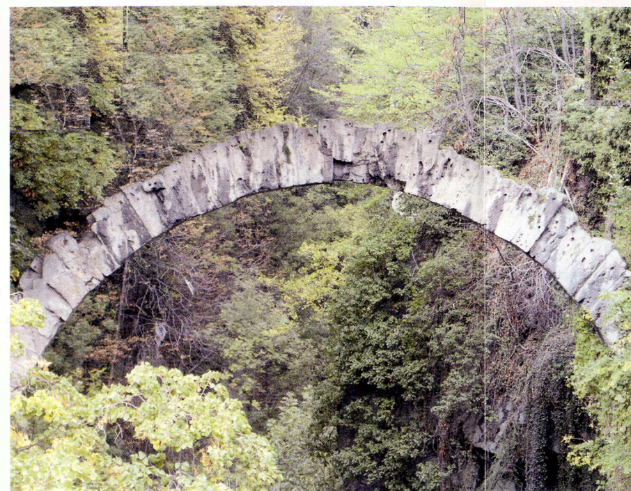
Veduta dei resti dell'arcata del ponte
