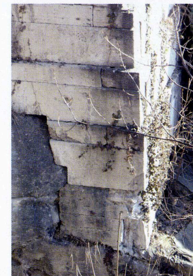
Particolare della lavorazione dei blocchi del ponte
