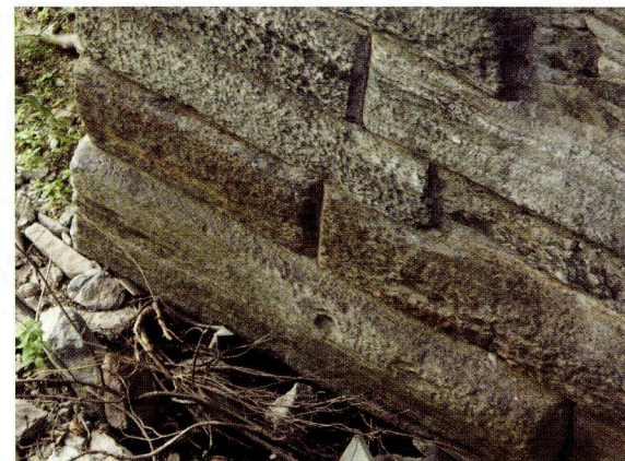
Particolare dell'incavo per il sollevamento dei blocchi
