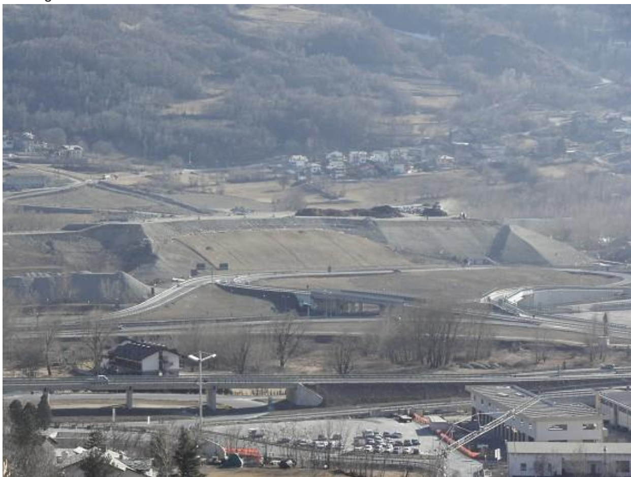
Veduta frontale della discarica di Brissogne
