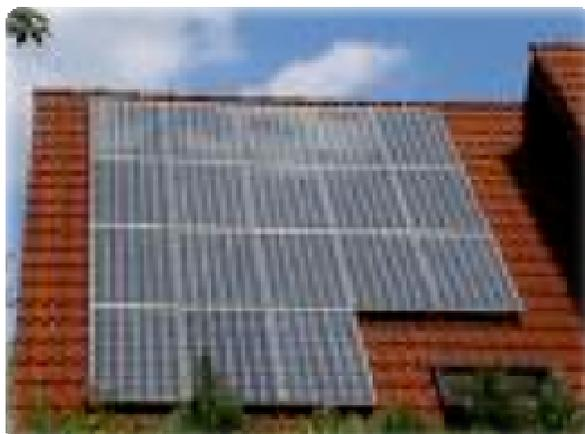
Installare **1 kWp** significa occupare una superficie di circa **7- 8 mq** (di moduli fotovoltaici in silicio cristallino o policristallino) con un costo tra **3.500 e 5.500 euro a kWp**
