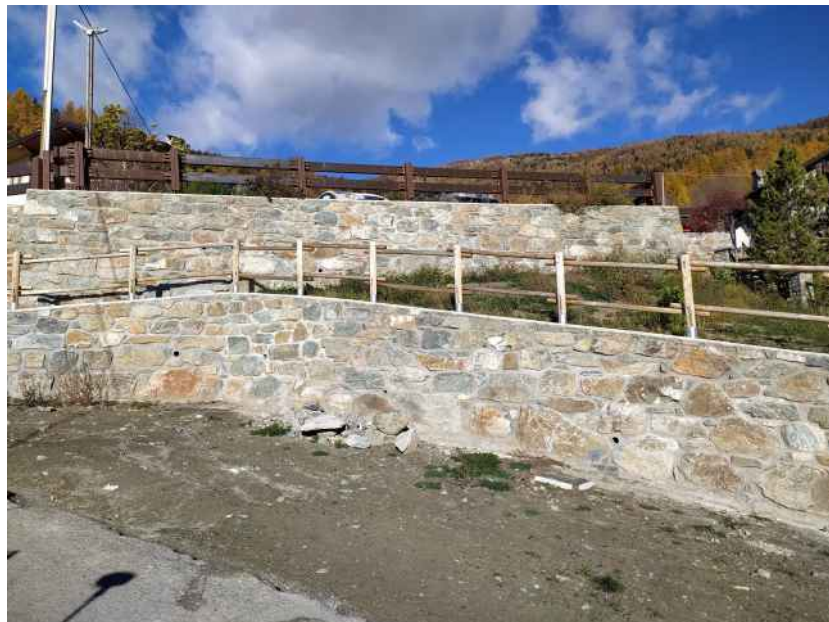
Figura 2.3: Vista dalla strada regionale dell'area in cui verrà realizzata la nuova cabina. Il muro in primo piano ospiterà la cabina.
