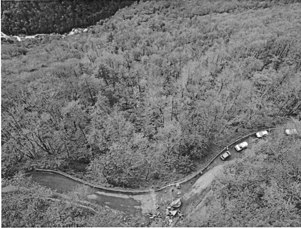
Fig 7: vista aerea della strada comunale e del versante compreso tra quest'ultima e la strada regionale.
