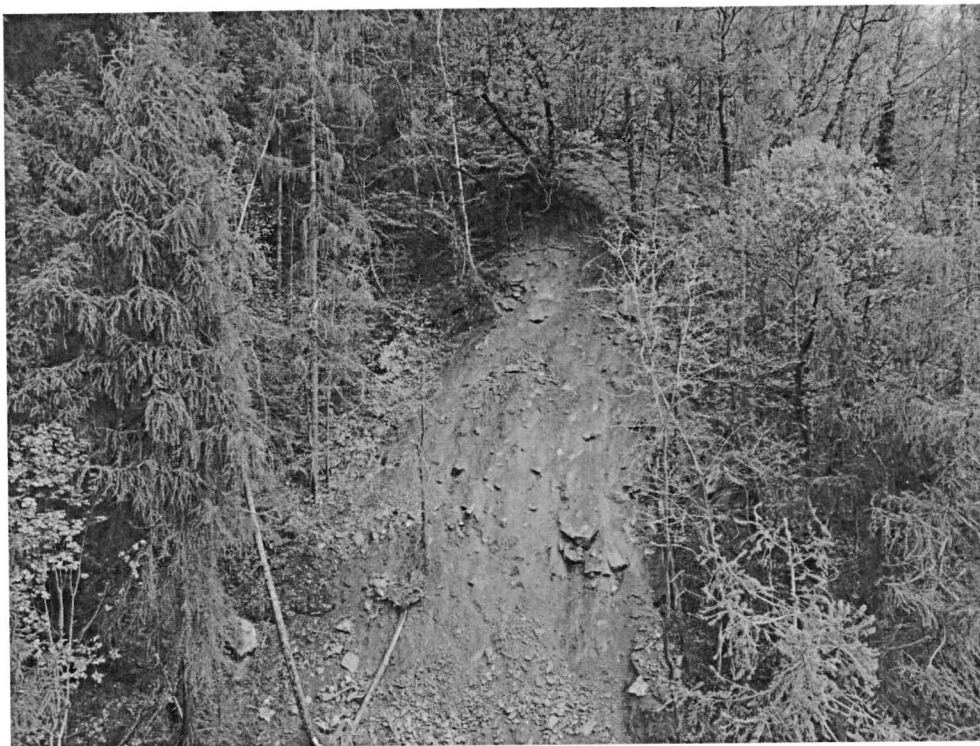
Fig 5: particolare della nicchia di distacco.
