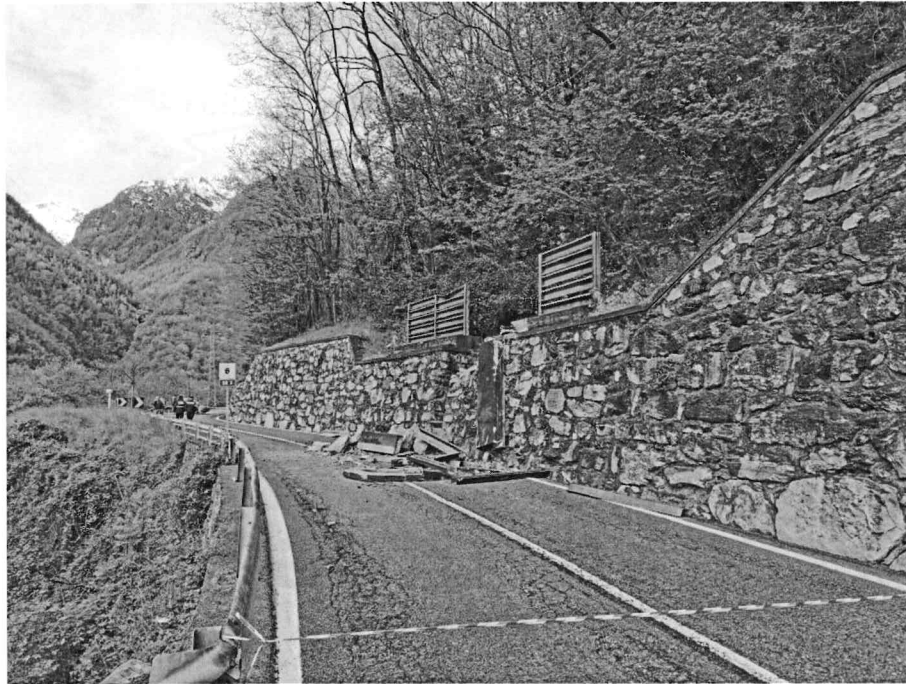
Fig 1: impatto su strada regionale con abbattimento barriera rigida. In questo caso i blocchi hanno sorvolato la strada e sono precipitati nel torrente Ayasse.
