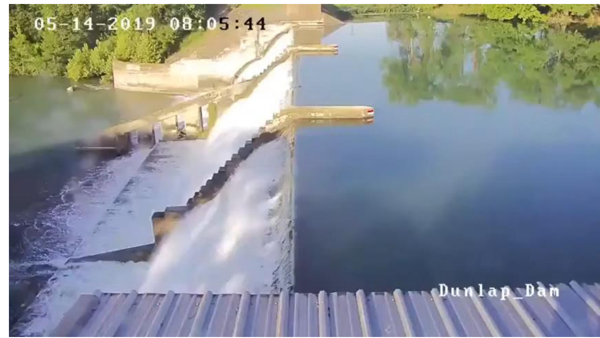
Rupture du barrage de Dunlap Lake (2019) Cedimento della diga del lago Dunlap (2019)
