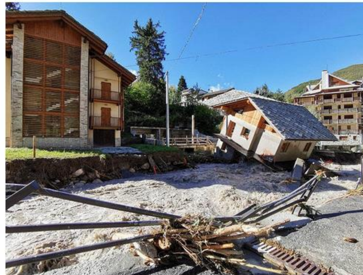
Sabato 3 ottobre 2020: erosioni spondali di un rio affluente del Vermenagna, in piena straordinaria, compromettono nella notte precedente un'abitazione a Limone Piemonte, località tra le più funestate dagli effetti delle piogge alluvionali al Nord-Ovest italiano. L'edificio, come altri, si trovava tuttavia in una posizione chiaramente a rischio alluvionale, a dispetto di quanto scriveva oltre due secoli fa Albanis de Beaumont nella citazione utilizzata come esergo di questo articolo (f. Giorgio Bernardi, Ente di gestione Aree Protette delle Alpi Marittime ).
