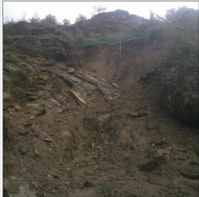
Issogne, località Creton, frana di scivolamento ha raggiunto la strada danneggiandola
